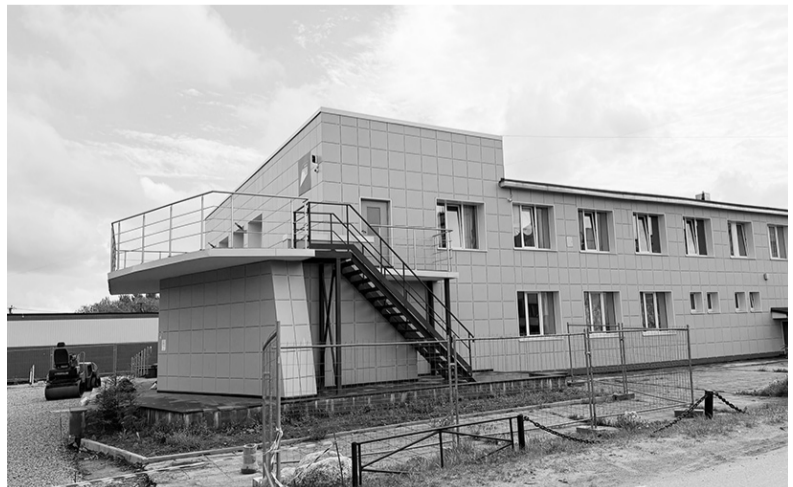
Сельский ДК после ремонта
