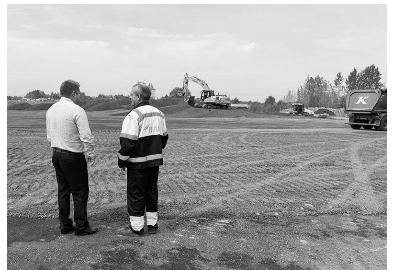
На осмотре строительного объекта в Отрадном
