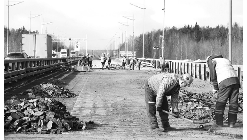
Ремонтные работы на мосту через реку Нева
